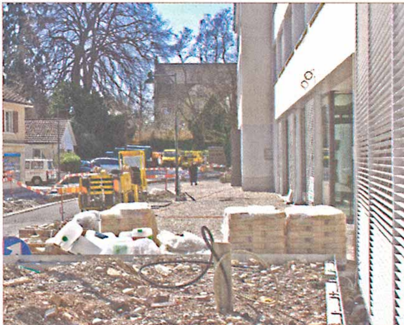
Hauptstrassensanierung läuft auf Hochtouren: Blick vorbei an der neuen BLKB-Fassade.
