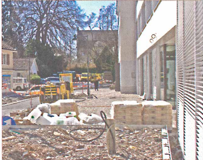
Hauptstrassensanierung läuft auf Hochtouren: Blick vorbei an der neuen BLKB-Fassade.
